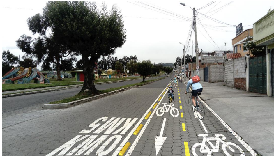
Foto 8 Inicio de la Ciclo Ruta Calle Juan Montalvo
