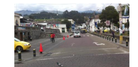
Intersección Semaforizada Bolívar y Terán. Tramo Bolívar señal en el piso mal ubicada genera mala canalización para vehículos.
