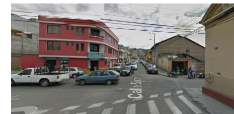
Intersección Semaforizada Sucre y Juan Montalvo. Déficit señalización horizontal en Juan Montalvo.
